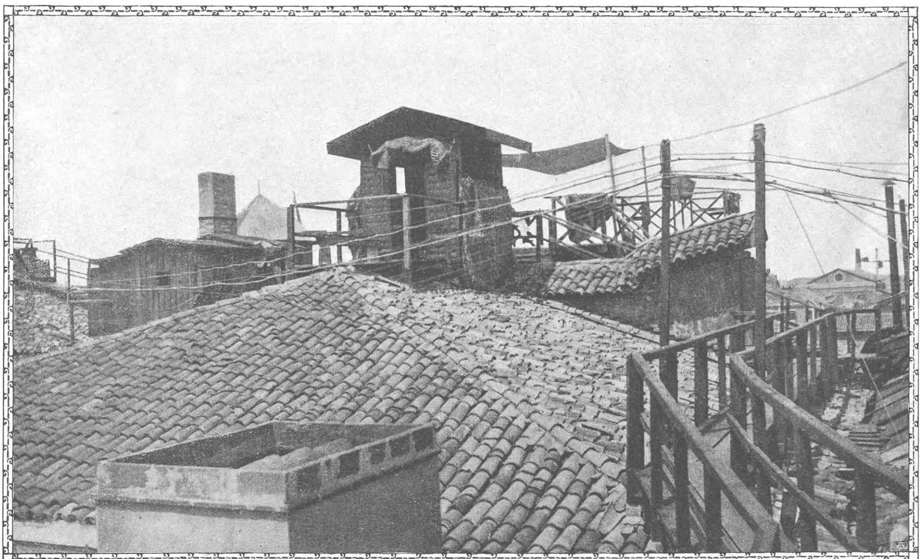
Sorsero sui tetti strani villaggi antiaerei...
