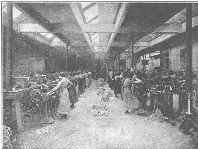
Sala saldatrici elettriche della catena.
