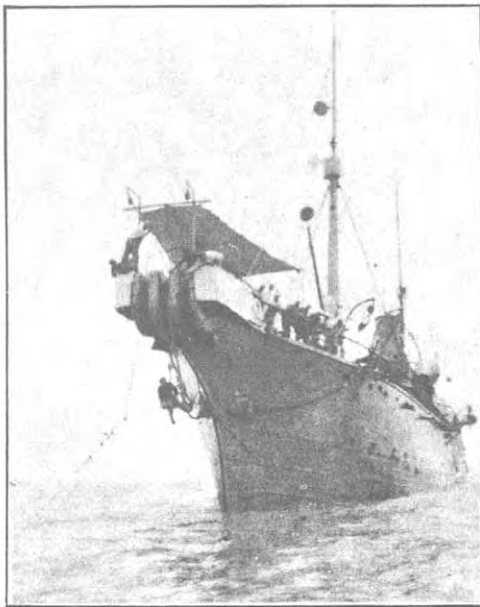
Riparazione di un cavo.
