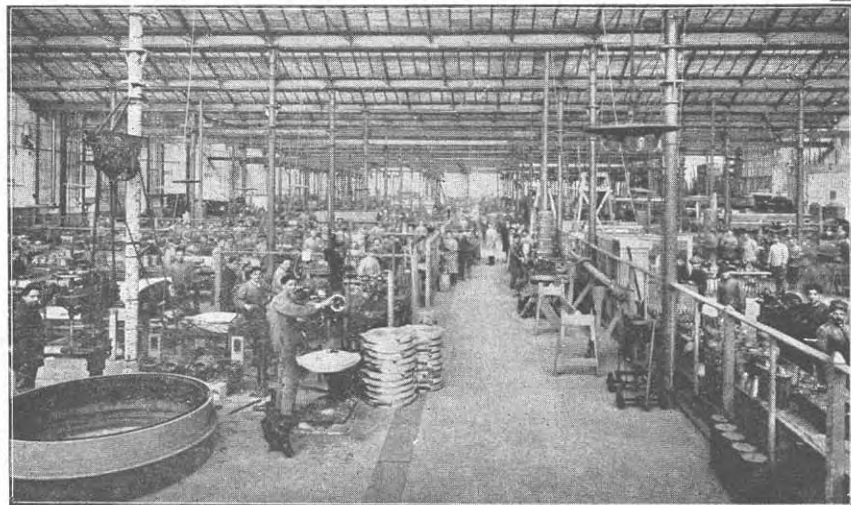
Veduta della sala principale delle macchine.
