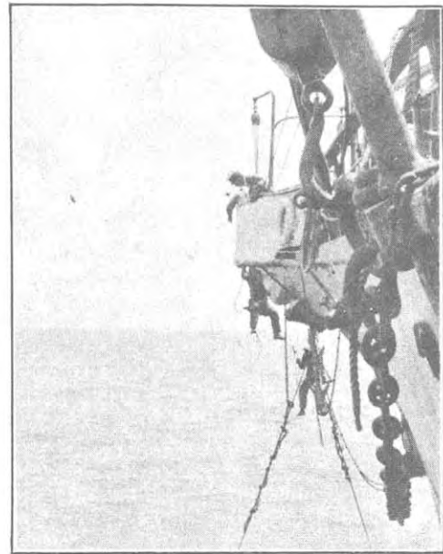
Riparazione di un cavo.
