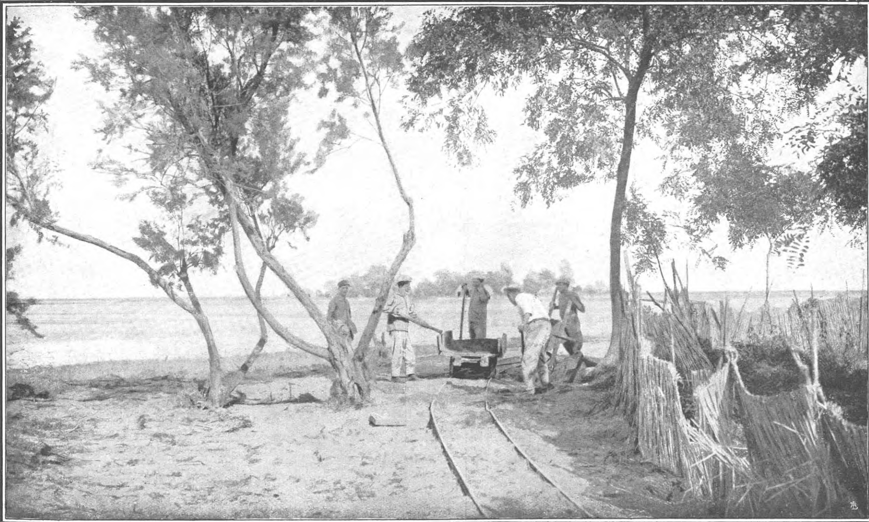
Porto Buso: lavori di Bonifica.
