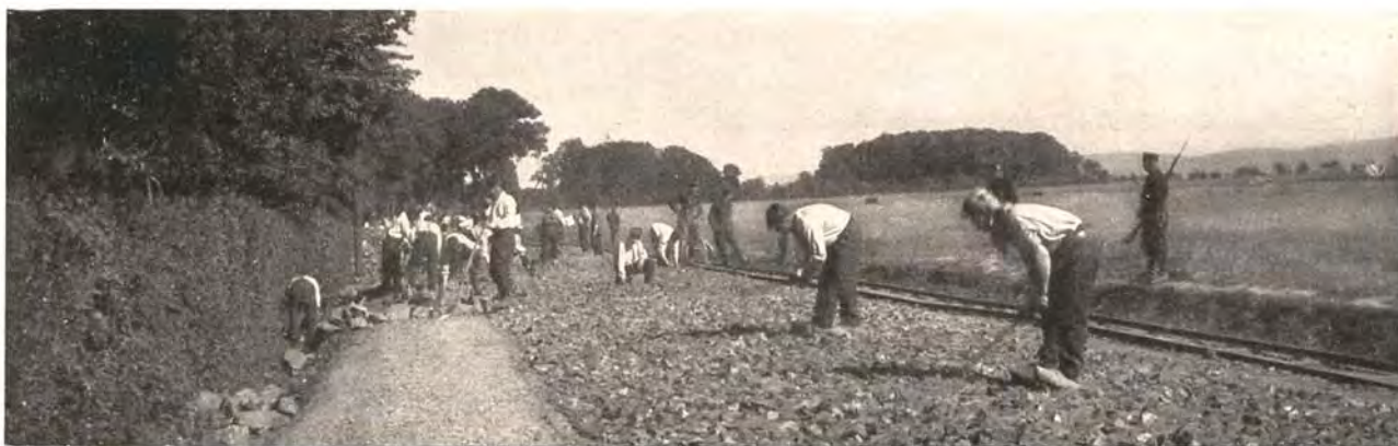
130. Minden I. Beim Wegebau. — Construction de chemins. — Road construction. — En la construcción de caminos. — Постройка шоссе подлѣ Миндена I.
