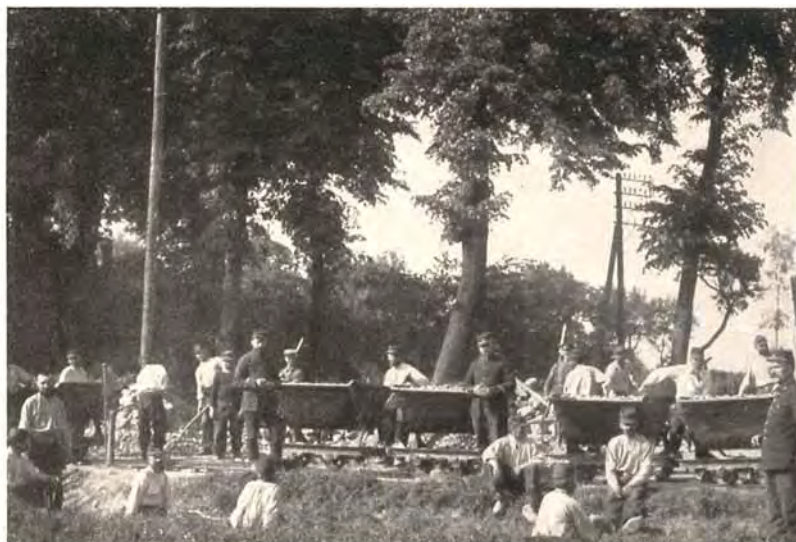
129. Minden I. Beim Bau der Feldbahn. — Pose du chemin de fer portatif. — Building a field railway. — Construyendo un ferrocarril de via estrecha. — Постройка полевой дороги. Минденъ I.
