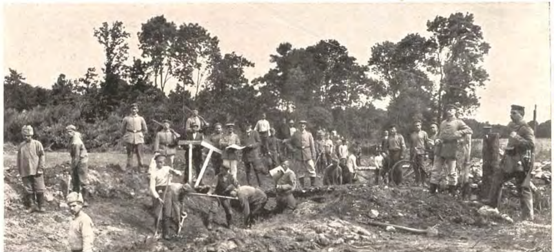
126. Wasbek. Beim Grabenbau. — Creusement de tranchées. — Digging trenches. — Construyendo trincheras. — Постройка рововъ. Васбекъ.
