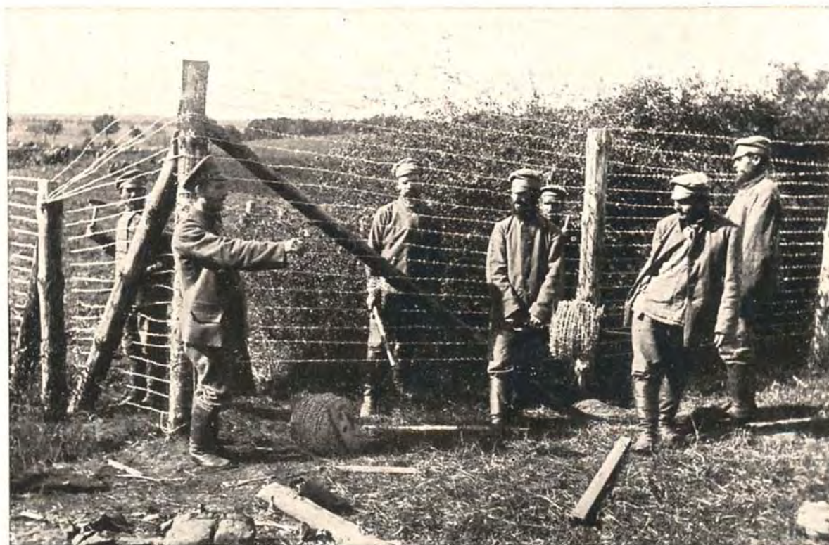
41. Bütow. Anfertigung des Lagerzauns. — Construction de l'enclos du camp. — Making a camp fence. — Construcción del cerco del campamento. — Постройка изгороди для лагеря. Бютовъ.
