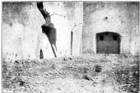
Wirkung im Fort Manouviller. Zerstörte Grabenstreiche.
